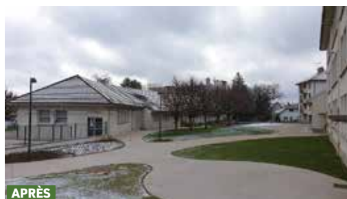
La cour d'école Pierre et Marie Curie après les travaux d'adaptation et de renaturation.
