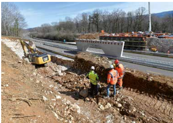
Le passage en construction, mars 2022.
