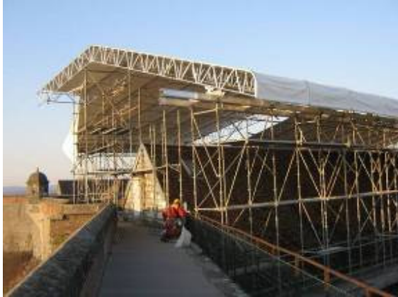
Installation d'un parapluie sur l'arsenal de la citadelle
