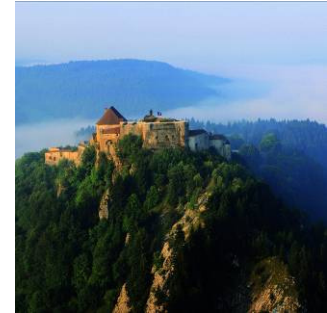
1. Fort de Saint-André à Salins-les Bains (39)
